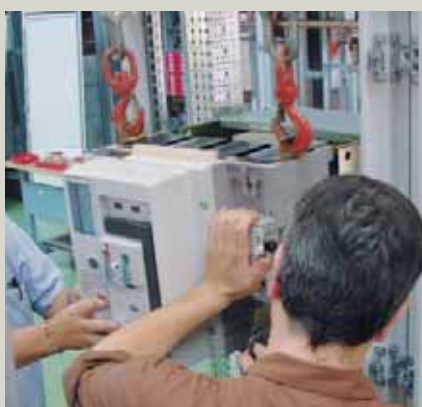
Установка аппарата DMX выкатного исполнения
