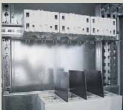
Крепление на монтажной рейке
