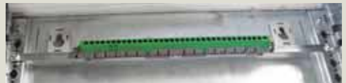
Крепление плоской рейки непосредственно к монтажным стойкам.
