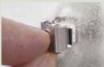
Установка клипс с задней стороны металлической монтажной пластины
