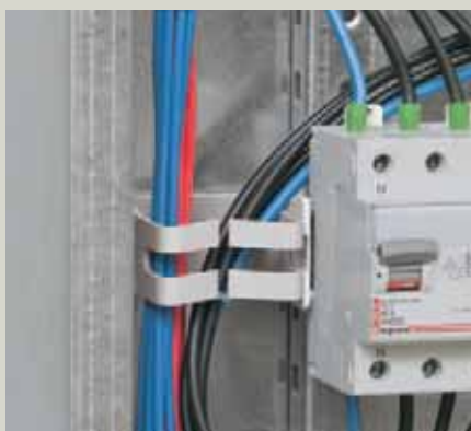
Фиксация вертикального жгута проводов.
