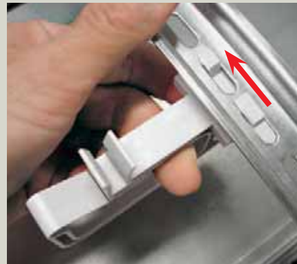
Установка держателей горизонтальных проводов
