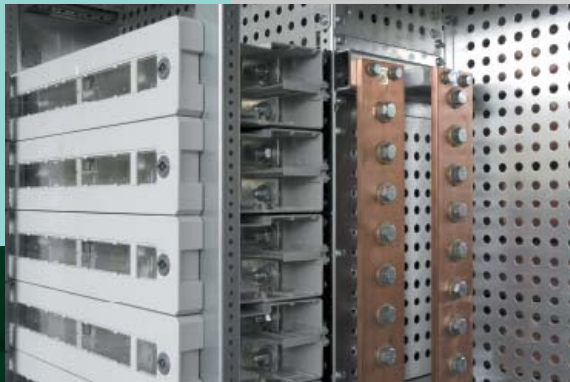
Внутренние секционные перегородки в формах 2b и 4b.
